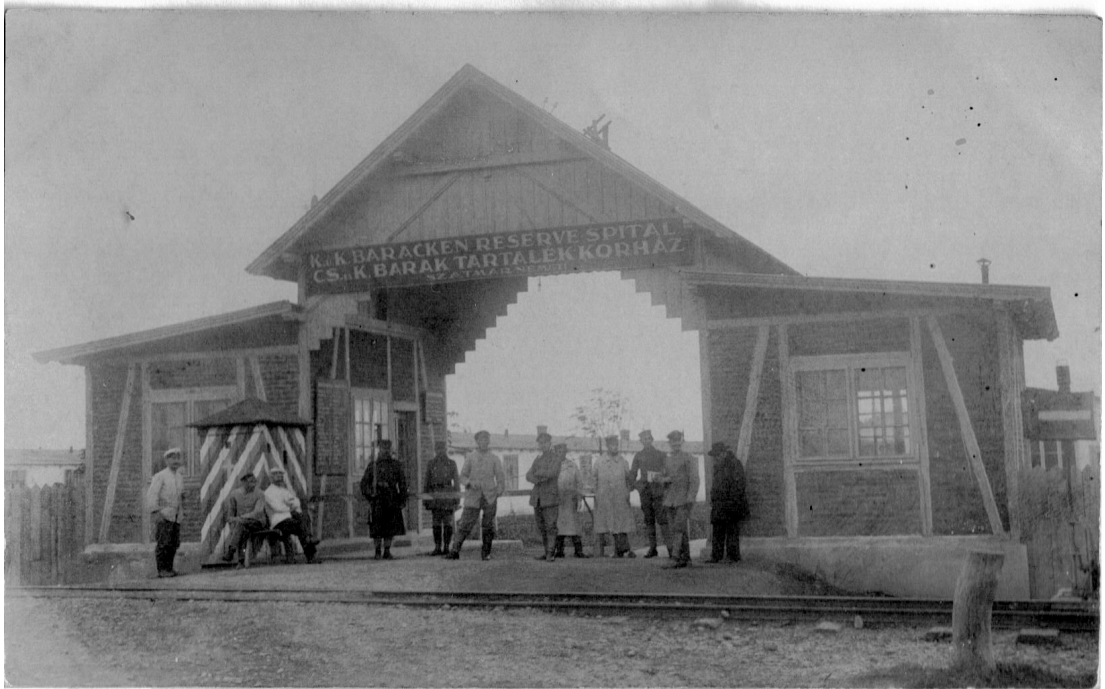
8. Intrarea în spitalul de barăci Satu Mare. Localizare: zona străzii Vulturului - pe actualul amplasament al unității militare. Funcționare: 1915-1919. Sursa imaginii: Jurnalul asistentei medicale Maria Dickhaeuser, publicat pe platforma: https://www.europeana.eu/portal/ro/record/2020601/contributions (ultima accesare: 21.02.2018).
