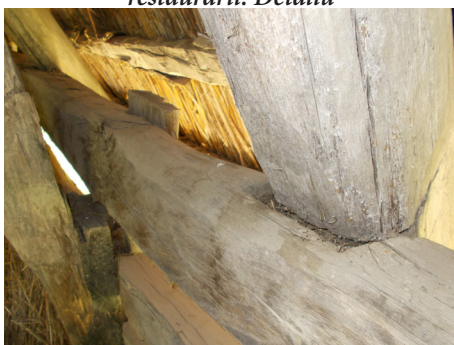
Fig. 6. Șura din Gherța Mare. Detaliu îmbinare cununa dea jos pe furcă și un corn pe cunună
