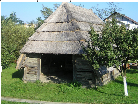
Fig. 7. Șura în furci pe tălpi din Gherța Mare la Muzeul Țării Oașului
