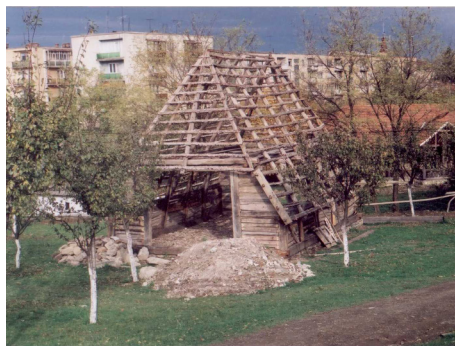
Fig. 4. Șura în furci pe tălpi din Gherța Mare în timpul restaurării la Muzeul Țării Oașului. Anul 2002
