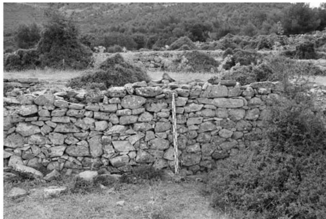
Fig. 13. Mur d'époque moderne.
