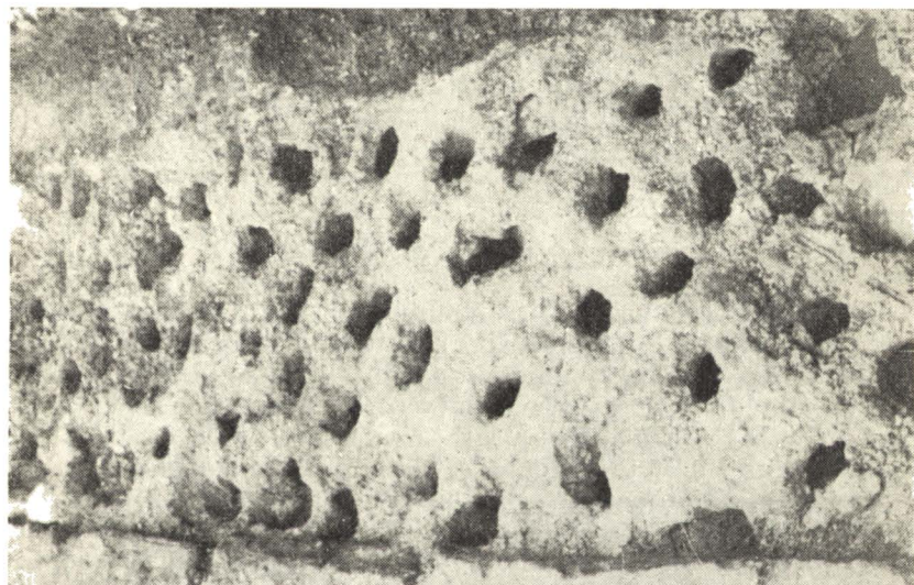
Fig. 12. — Diferite faze ale descoperirii substrucției de lemn în apă.
