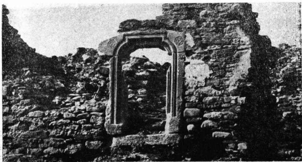
Fig. 48. — Moldovița. Cadrul ușii camerei centrale de la etaj.
