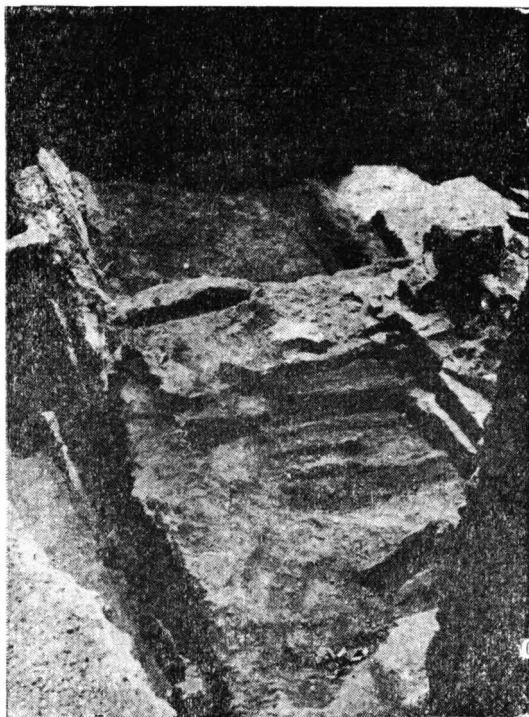
Fig. 29. — Aspectul unor pivnițe de locuințe, situate la N de Curtea Domnească (sec. XV).
