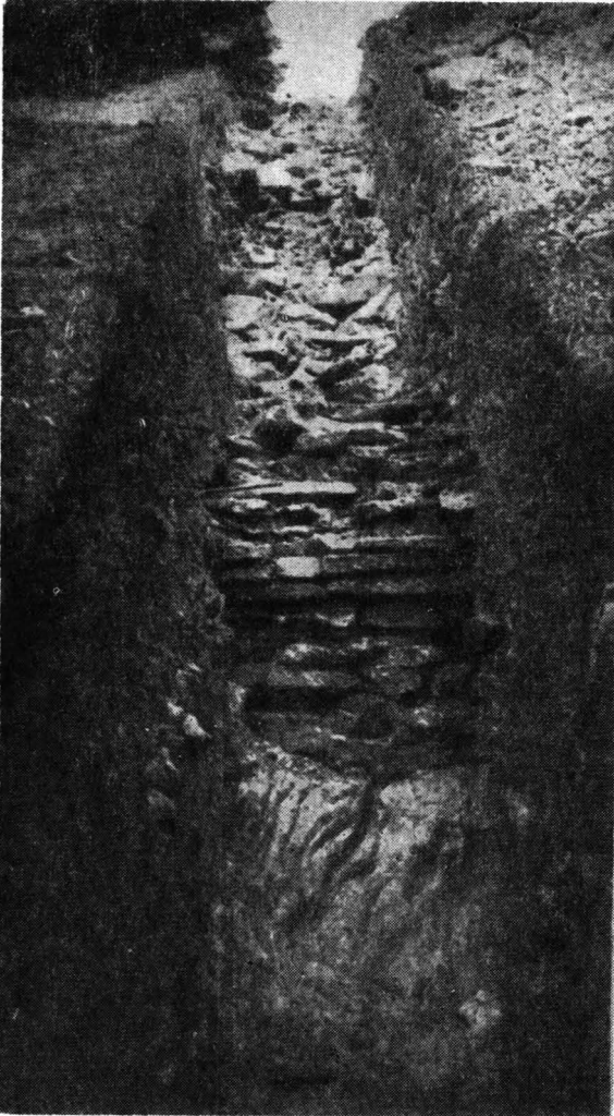
Fig. 2. — Zidul cetății făcut din lespezi de piatră fără mortar.
