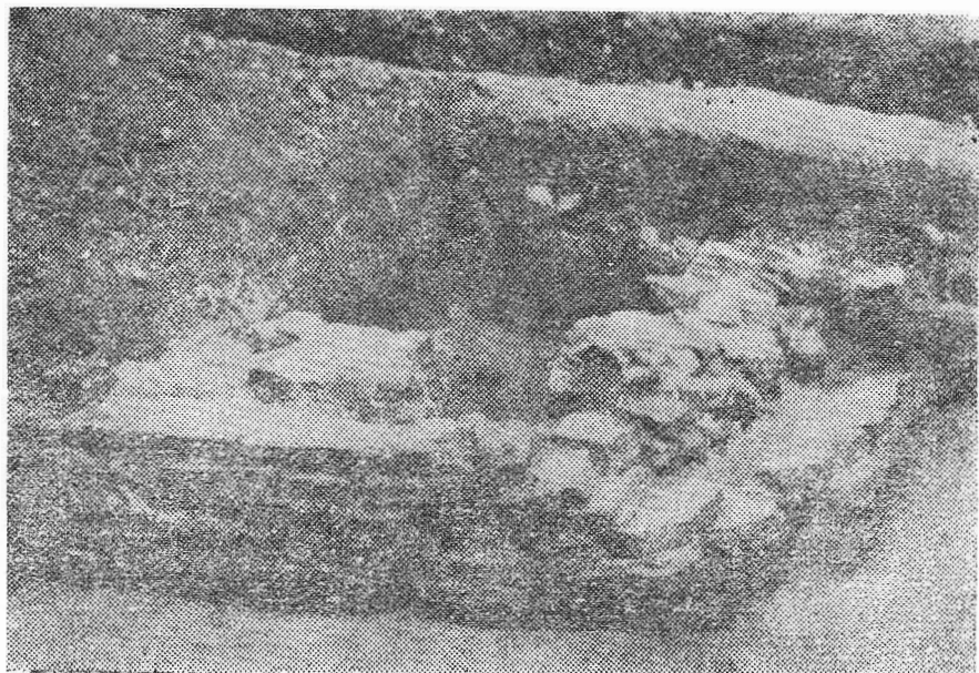
Fig. 10. Valea Mănăstirii. Colțul de sud-vest al construcției, în S. IV a, vedere dinspre sud-vest.
