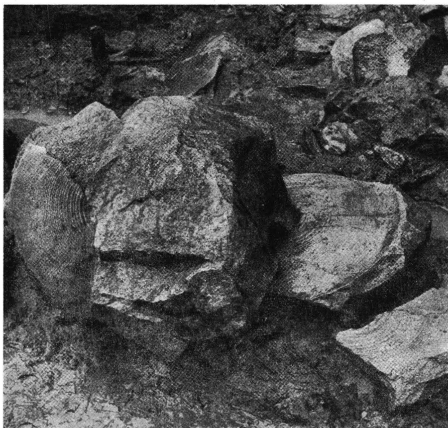
Fig. 5. — Pietre de moară. Se remarcă creștăturile produse de măcinarea cuarțului aurifer.
