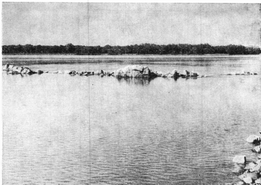
Fig. 1. — Porțiune din latura de nord a zidului cetății, aflat sub apă, fotografiat într-o perioadă de mare scădere a apelor Dunării. În ultimul plan, malul stîng al fluviului.
