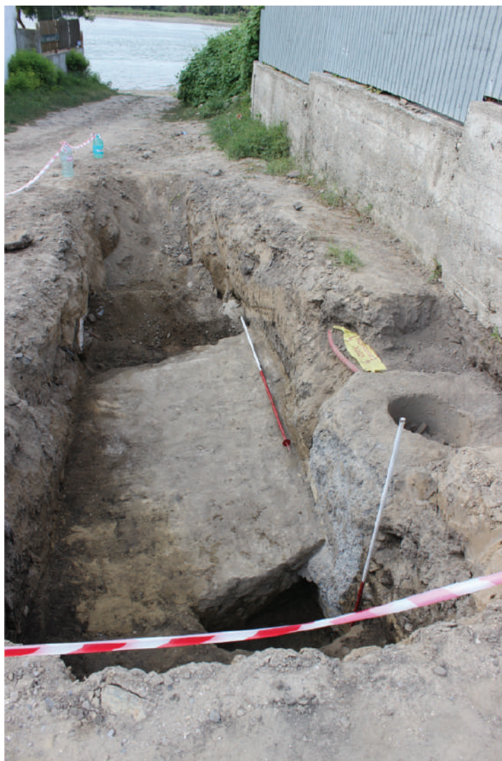
Fig. 9. Nufăru. Str. Ulmului, 2017. Tronson din curțina bizantină de nord, cu intervenția neautorizată din anul 2015 pentru reamplasarea stălpului electric. Vedere dinspre sud. Fundație modernă deasupra și în zidul de incintă, cu afectarea paramentului sudic al acestuia.
