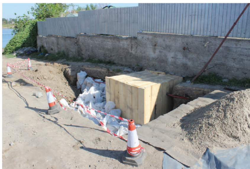
Fig. 15. Nufăru. Str. Ulmului, 2017. Tronson din cortina bizantină de nord. Caseta destinată intervențiilor reparatorii asupra porțiunii de zid distruse și pregătirea pentru astuparea cu pământ a suprafeței deschise.
