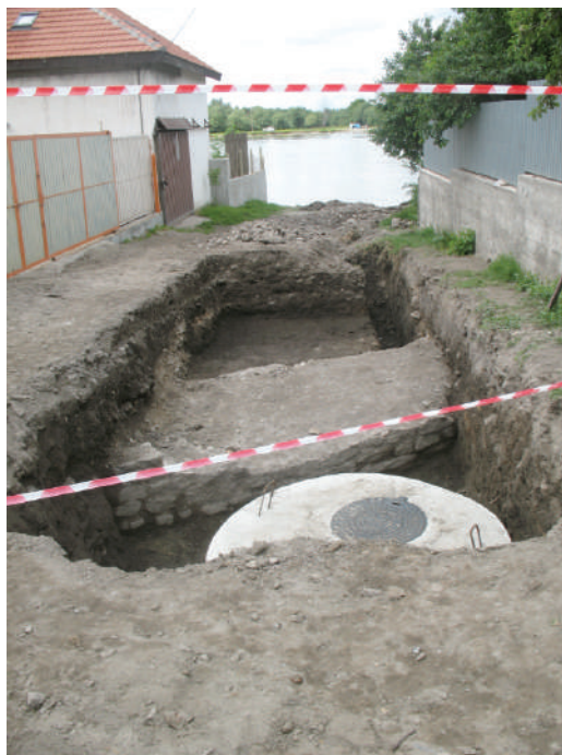
Fig. 5. Nufăru. Str. Ulmului, 2010. Tronson din curțina bizantină de nord cercetată, cu stația de pompare amplasată la sud. Vedere generală.
