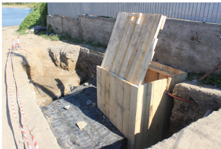
Fig. 14. Nufăru. Str. Ulmului, 2017. Tronson din cortina bizantină de nord. Protecție de lemn pentru caseta destinată intervențiilor reparatorii asupra porțiunii de zid distruse.
