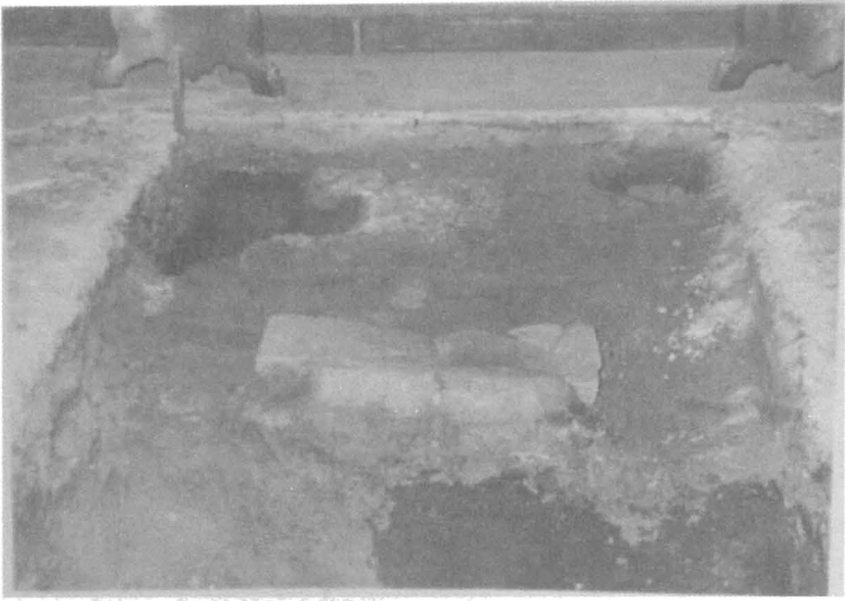
Fig. 5. Dalajul din sec. XVII și o piatră aflată lângă „solea”, la capătul estic al șanțului principal din biserică, stricate de prăbușirea turlei Pantocratorului.
