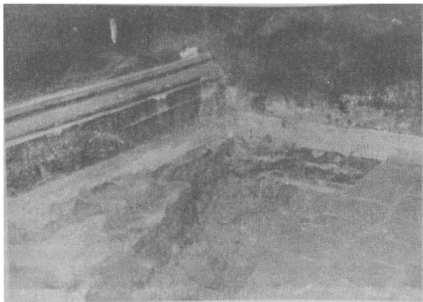
Fig. 4. Șanțul deschis spre strana stângă în biserică. Se observă dalajul sec. XVII și sub nivelul său „patul” dalajului sec. XVI.
