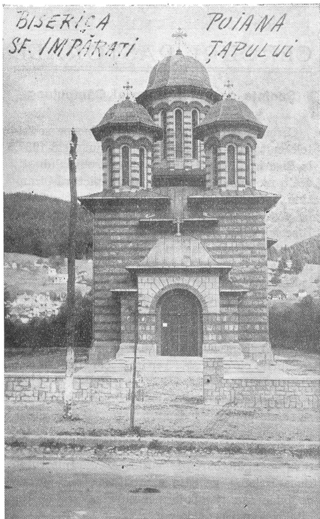
Biserica nouă „Sf. Impărați“ din parohia nou înființată dela Poiana Țapului, sfințită în toamna anului 1936.
