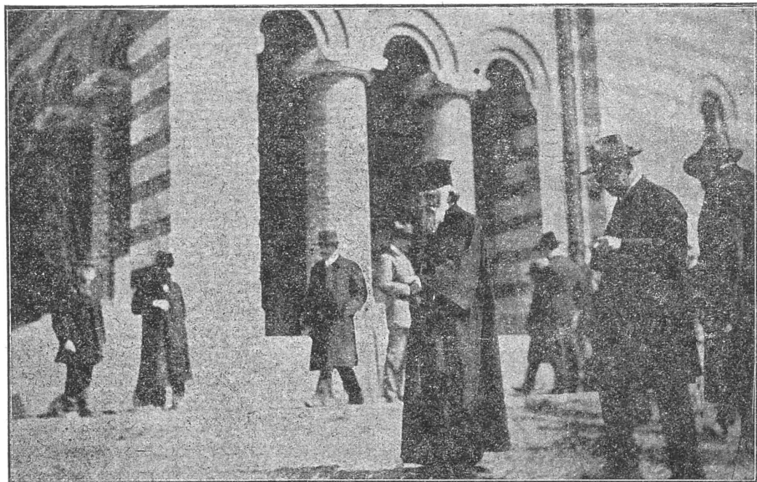
I. P. Sf. Patriarh Miron și Al. Lapedatu, Ministru al cultelor de pe atunci, inspectează stadiul, în care se afla zidirea catedralei „Vechea Mitropolie“ din Târgoviște, spre a lua măsuri pentru continuarea lucrărilor până la complecta lor terminare. 14 Aprilie 1925.
