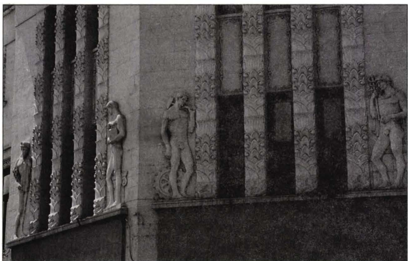
Fig. 3. Camera de Comerț și Industrie Arad, detaliu de fațadă.
