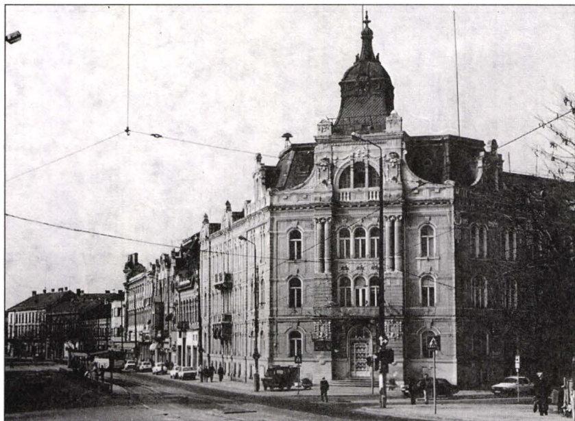
Imobilul Societății de Hidroameliorări Timiș-Bega, 1900-1902, Timișoara.
