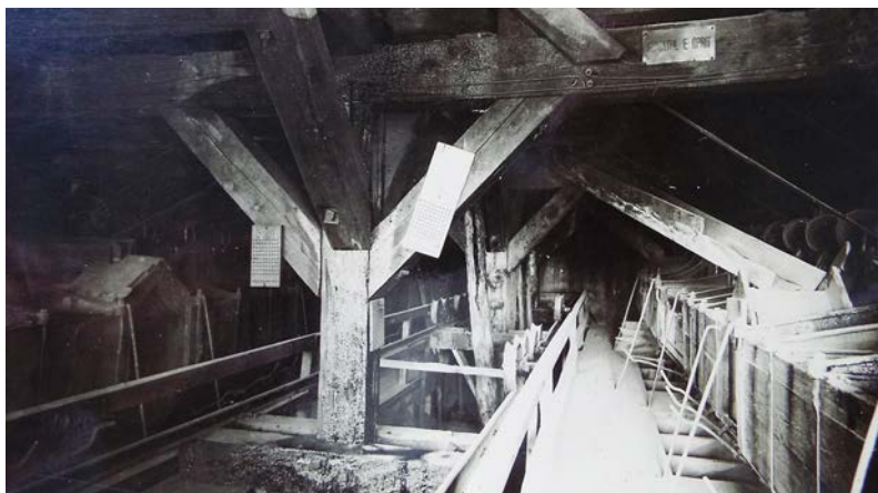
Instalația de prelucrare umedă a piritei, anul 1938.
