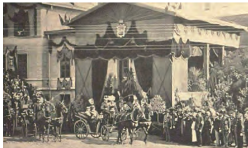
Fig. 6. Gara Orșova special amenajată pentru evenimentele dedicate inaugurării Canalului Sip
