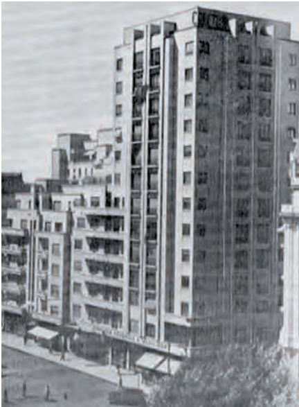
Figura 6. Blocul Carlton din București, cea mai înaltă construcție din beton armat din capitală în 1940
