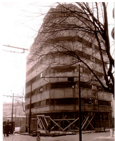
Figura 12. Blocul Austrului (demolat)
