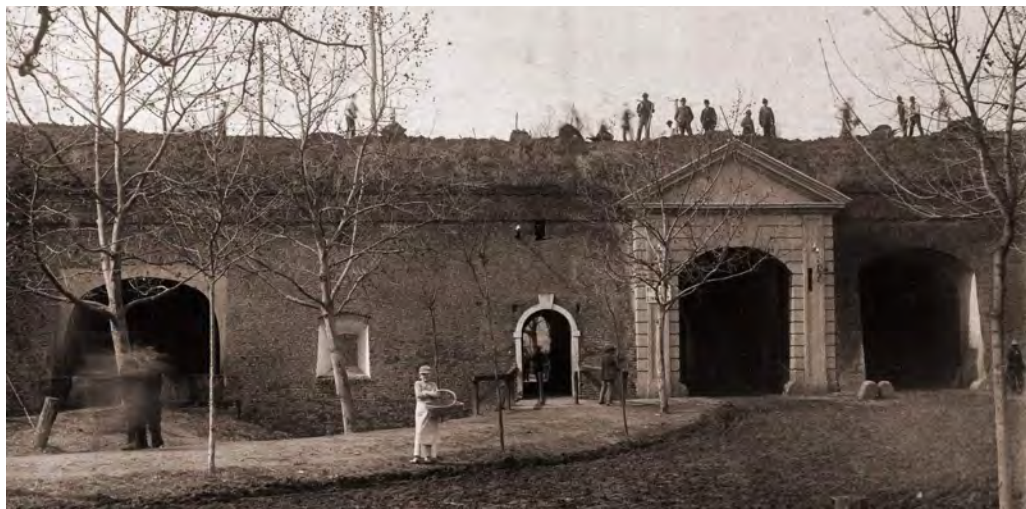
Demolarea zidurilor cetății (detaliu), poarta Transilvaniei. Sursa: Colecția de Fotografii a Muzeului Național al Banatului
