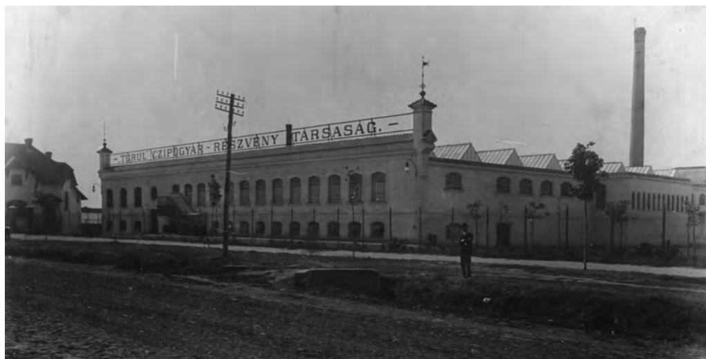
Fabrica de pantofi Turul construită în anul 1900 și pusă în funcțiune în 1901, cea mai mare fabrică de profil din monarhia dunăreană. Sursa: Colecția de Fotografii a Muzeului Național al Banatului.
