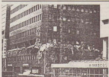
Cutremurul Kobe. Cedarea elementelor structurale ale nivelului 3.
