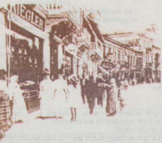
Calea Victoriei. Vedere de epocă
