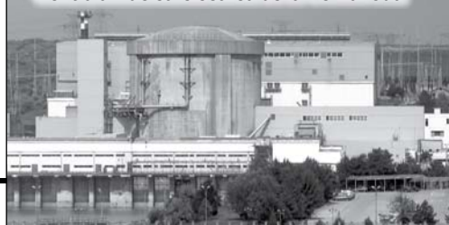
Centrala Nuclearelectrică de la Cernavodă
