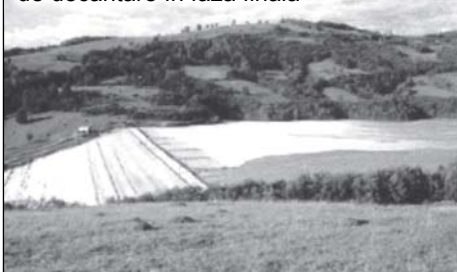
Vedere de ansamblu a unui iaz de decantare în faza finală
