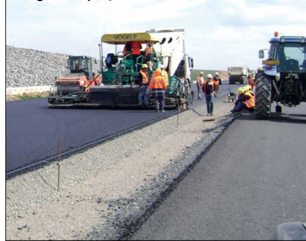
Imagine de pe șantierul autostrăzii A3
