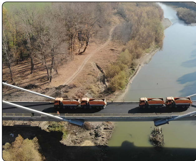
Fig.6 Podul peste râul Siret de la Sagna-Luța, județul Neamț, în timpul testării cu vehicule (Fototeca inginer Florea Sabin)
